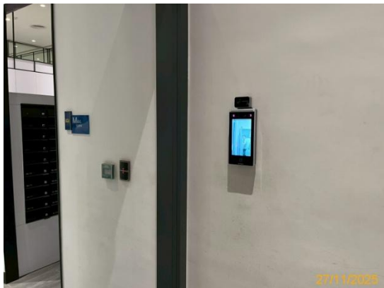
รูปที่ 2-20 ระบบควบคุมการเข้า-ออกอาคาร ด้วยระบบสแกนใบหน้าและระบบคีย์การ์ด
