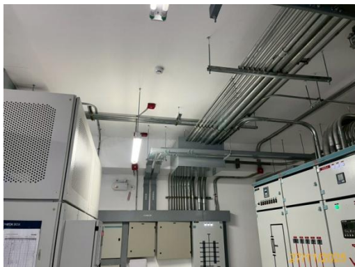
รูปที่ 2-41 จัดให้มีเครื่องตรวจจบบัควันในห้องหม้อแปลงไฟฟ้า
