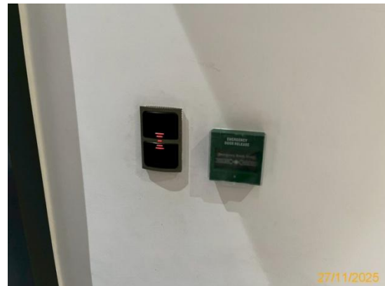
รูปที่ 2-20 ระบบควบคุมการเข้า-ออกอาคาร ด้วยระบบสแกนใบหน้าและระบบคีย์การ์ด
